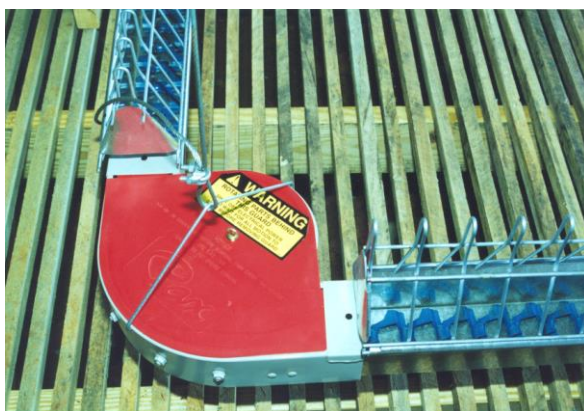
Фитинг решетки с углом, выполненный надлежащим образом, с установленными концевыми накладками решетки
